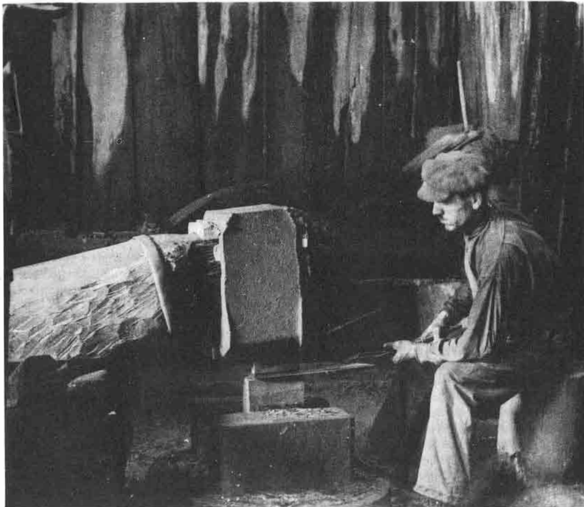
Medzevský kováč pri kovaní rýla pomocou mechanického buchadla poháňaného vodnou energiou – foto 1940, repro H. Bakaljarová.
