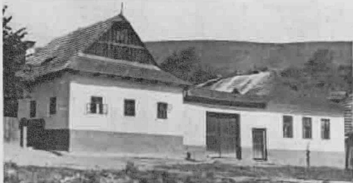
Murované trojosové domy, z komory sa na priečelí vyvinula ďalšia izba, dvor uzavretý bránou, Medzev (Metzenseifen, okr. Košice), kon. 19. a zač. 20. stor. – foto 1940, repro H. Bakaljarová.
